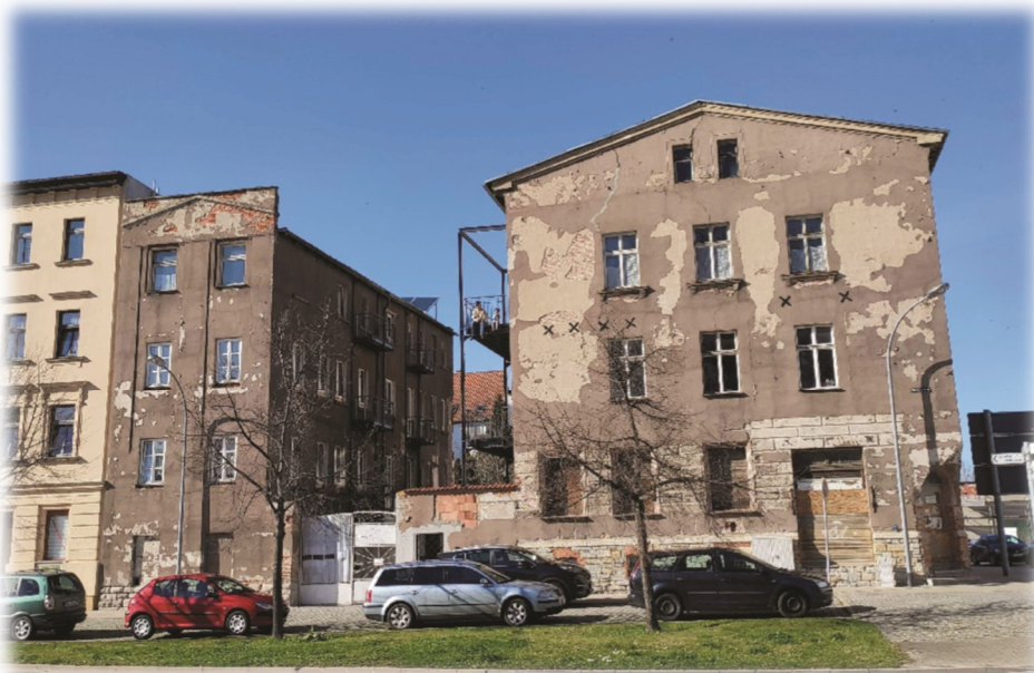
Die Ansicht von Süden - vor sowie nach der Sanierung.
