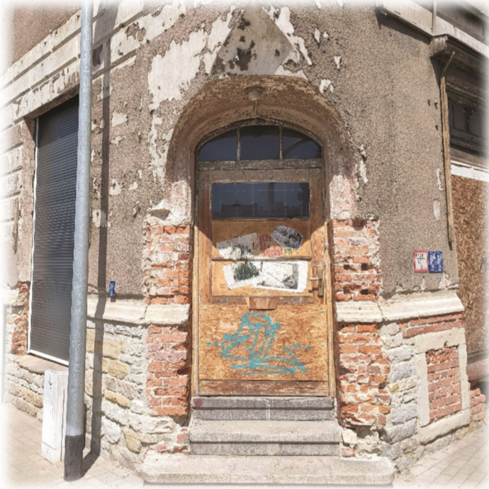
Das Eingangsportal vor der Sanierung
